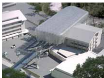
Blick von oben: Alter und neuer Gebäudekörper der Talstation.
