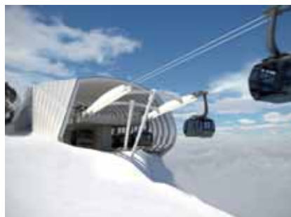
Ein 3-S-System verbindet Mittel- und Bergstation des Gaislachkogls.
