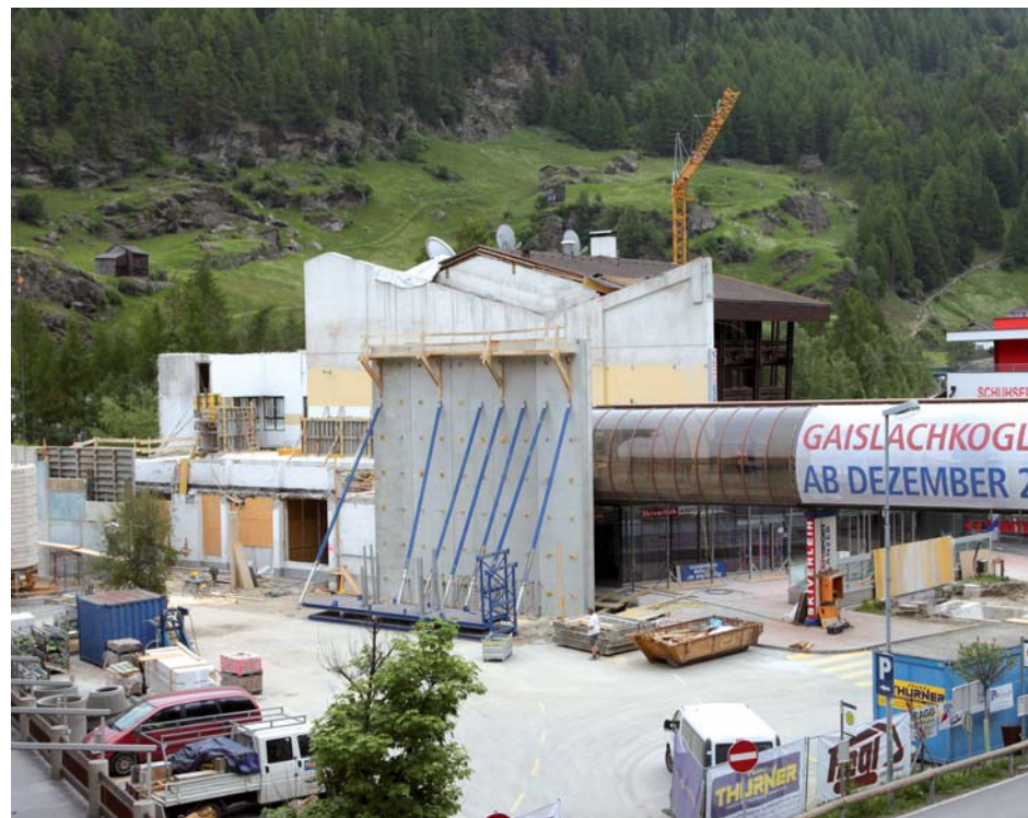
Im Juli 2010 beginnt die Montage der Stahlkonstruktion in den einzelnen Stationsgebäuden.
